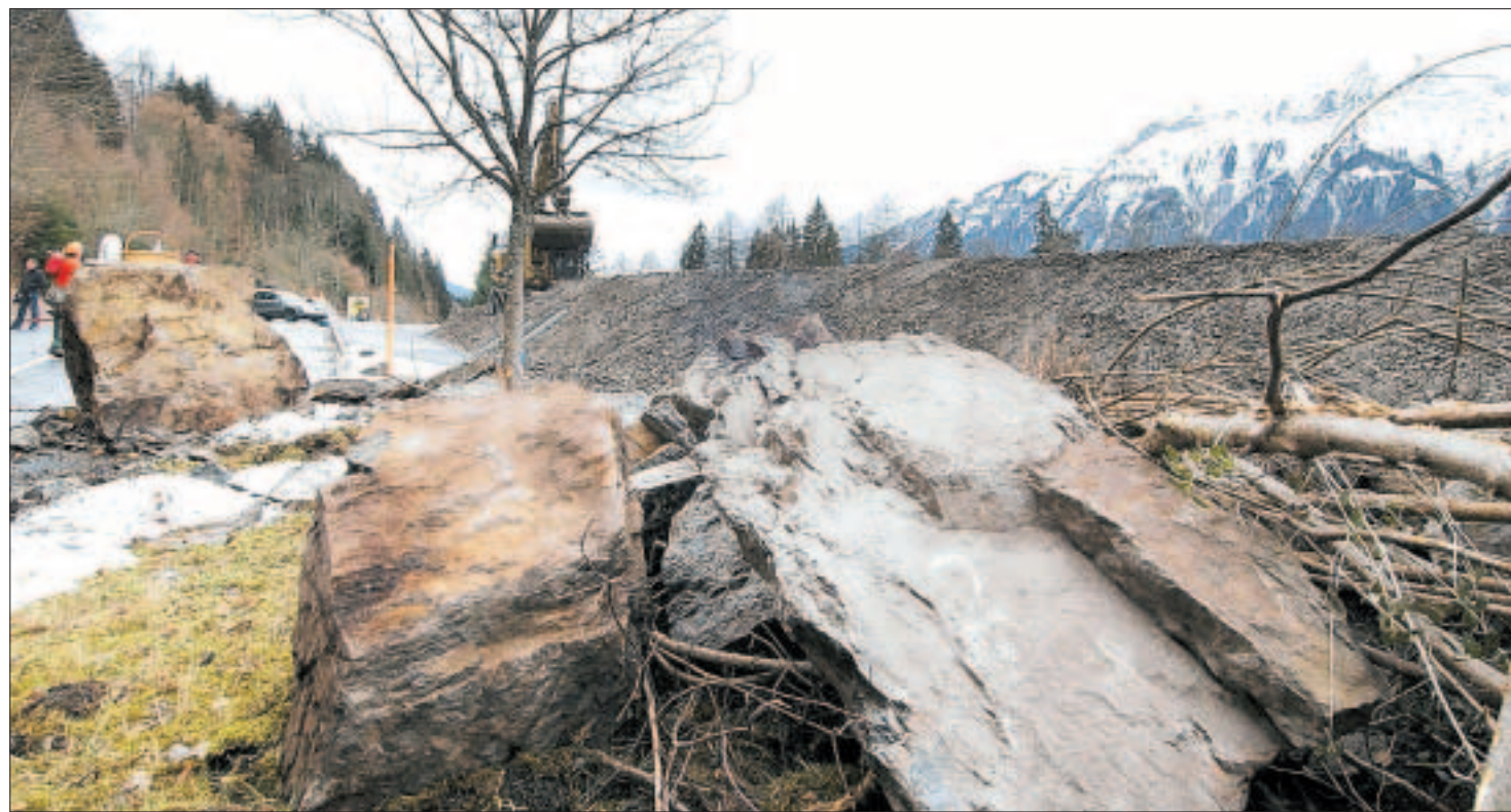
Der Damm (rechts hinten) soll vor weiteren Felsstürzen schützen: Gestern Sonntag wurde auf einer Länge von rund 50 Metern ein zwei Meter breiter Damm aus Aushubmaterial aufgeschüttet. Die A8 war ab 15 Uhr wieder normal befahrbar. BILD MARKUS HUBACHER
