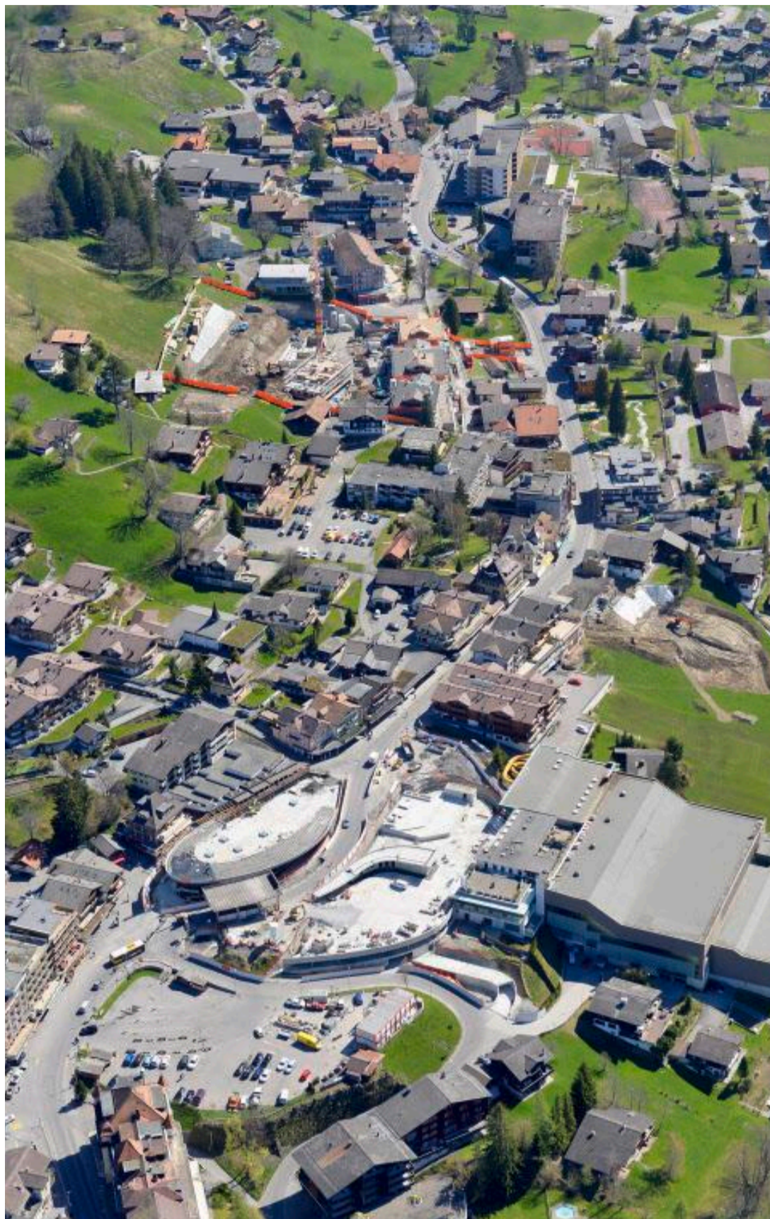
Das Dorf ist eine Baustelle: Vorne das entstehende Dorfzentrum, rechts in der Mitte der Neubau des Rendez-vous, oben links die Grossüberbauung Bergwelt, dort entstehen Appartements und ein Hotel. Bruno Petroni
